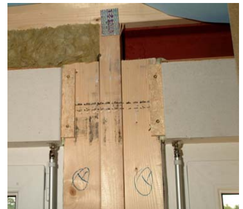
Dämmung der Stahlträger über Fenstern, Balkon- und Haustüren Abbildung 14
